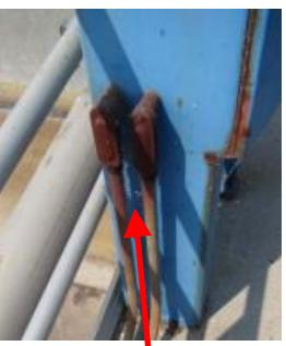
**Replace Corroded Electrical Conduits**
