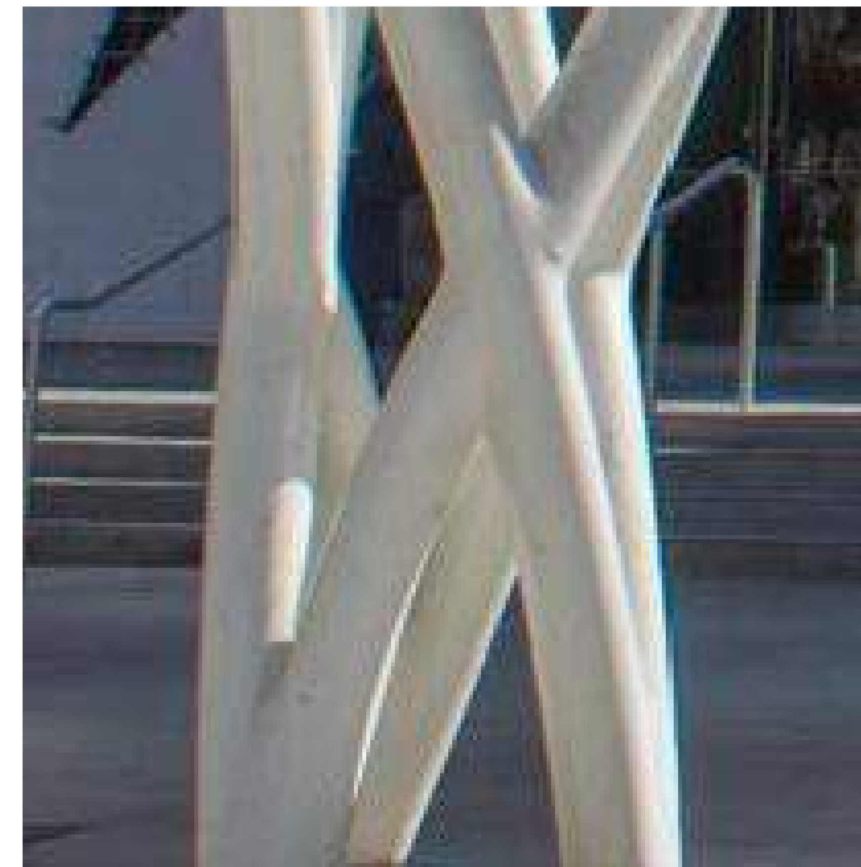
(D) TUBE STEEL Pavilion arches and columns
